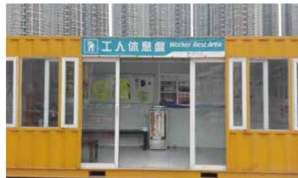
中国路桥香港 P2 填海及道路相关工程项目工地用货柜组装成空调休息亭让工友在炎热天气下消暑和休息
