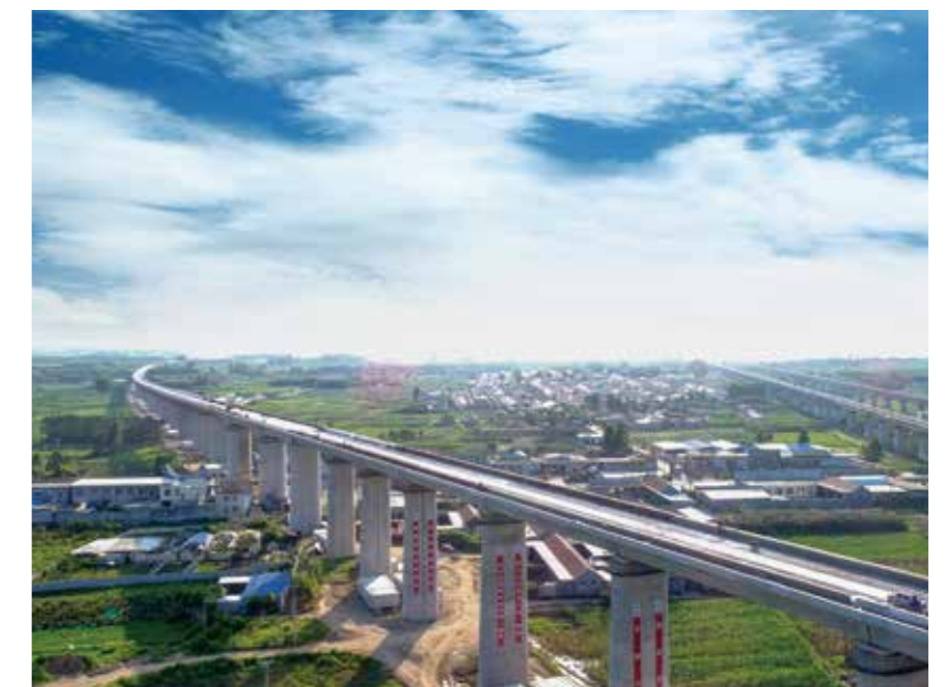
鲁南高铁设置污水集中处理设施
