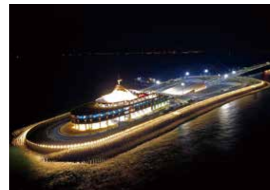
港珠澳大桥东人工岛亮灯
