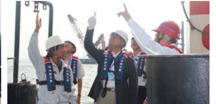
中交疏浚广航局深中通道项目开展国庆节前专项安全督查
