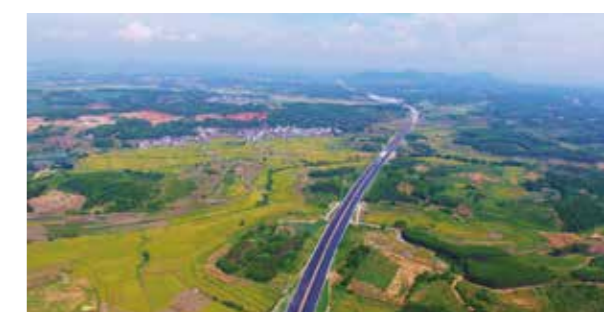
广西河池至都安高速公路工程
