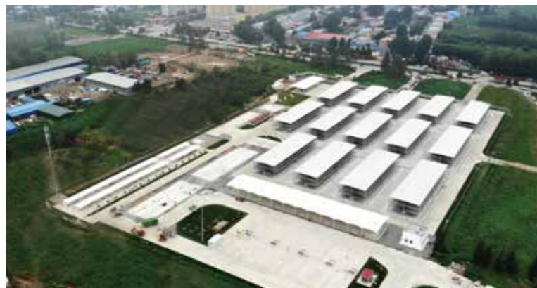
雄安新区首个城市交换中心立体停车楼项目竣工验收
