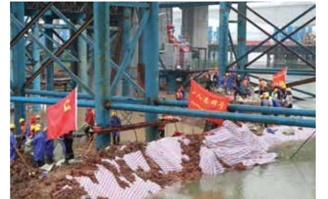
中交路建引江济淮项目部参加抗洪救灾工作
