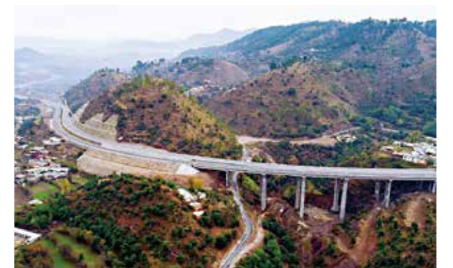
2020 年 7 月 28 日，巴基斯坦喀喇昆仑公路二期（赫韦利扬-塔科特）项目全线通车
