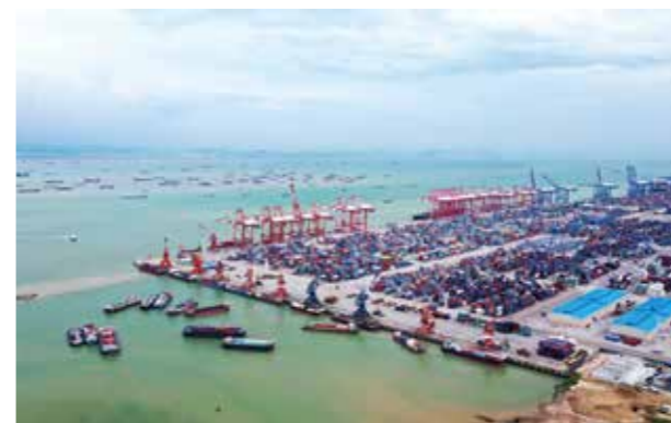
深水航道拓宽工程全线投入使用，广州港正式迈入“双车道”新时代
