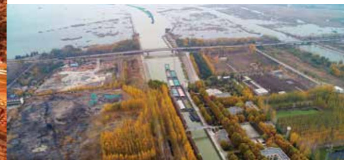
山东京杭运河航道整治工程
