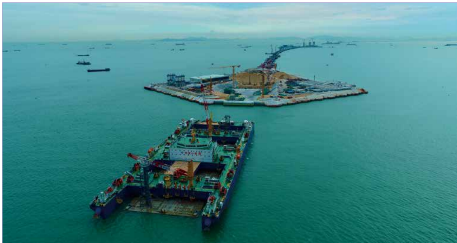
深中通道首节沉管完成浮运安装
