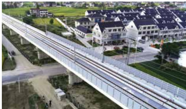
“沿海通道”重要组成部分——江苏盐城至南通高速铁路试运行
