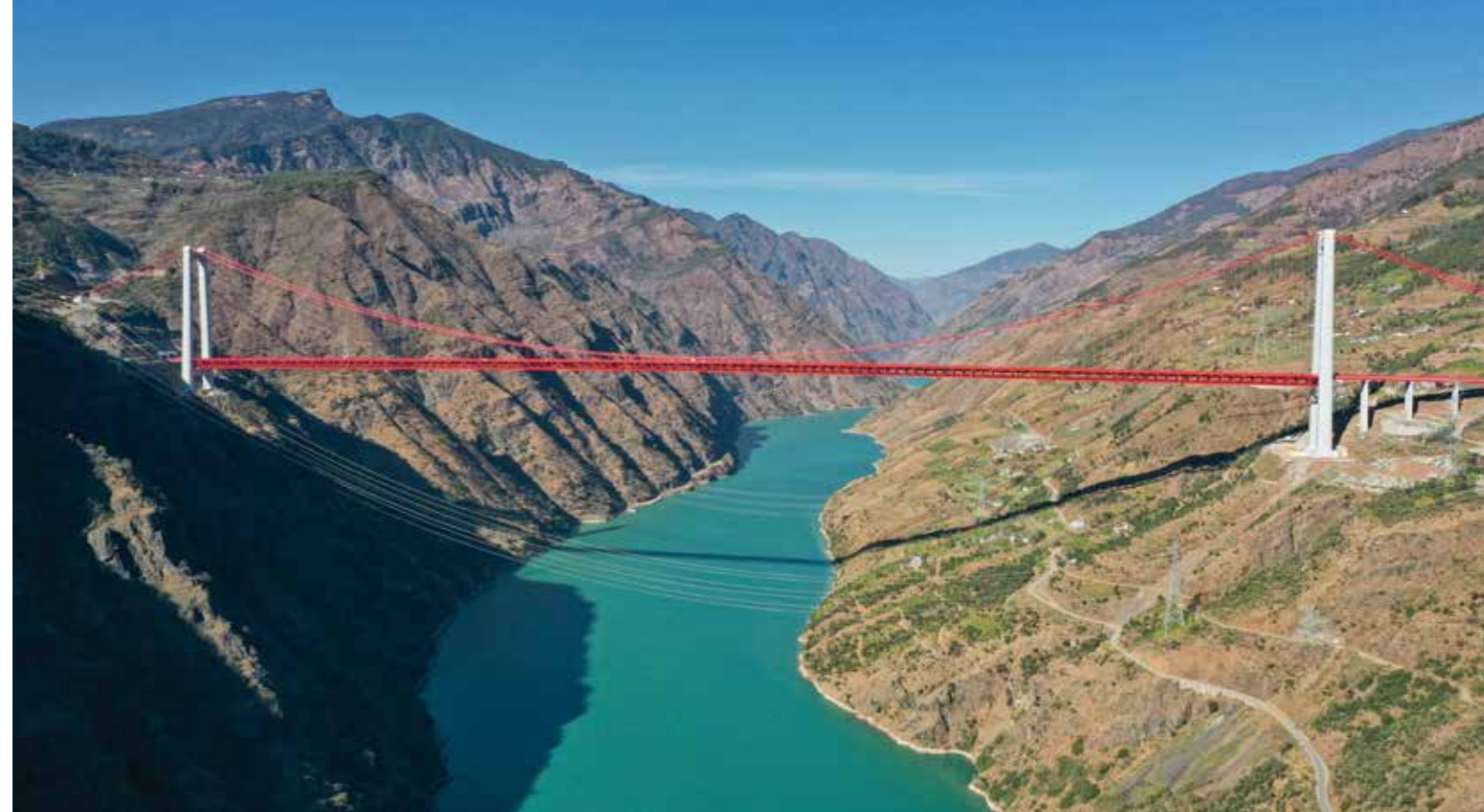
华丽高速金安金沙江大桥全景景象
