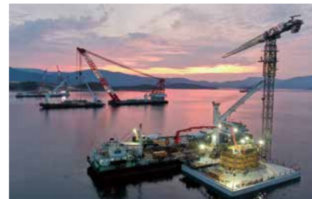
克罗地亚佩列沙茨跨海大桥全长 4 公里，2020 年克服疫情影响不利影响，各项建设内容稳步推进
