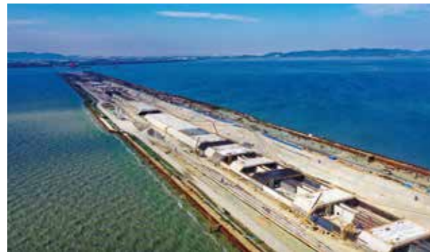
国内最长水下隧道——太湖隧道实现全部陆岛通道转换
