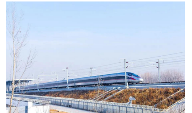
京雄城际铁路
