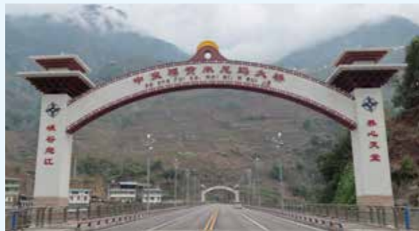
10 月 18 日，中交福贡木尼玛大桥主体工程完工
