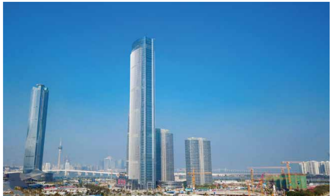
横琴广场竣工
