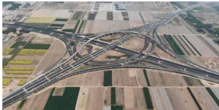
北京至雄安高速公路雄安段全幅贯通
