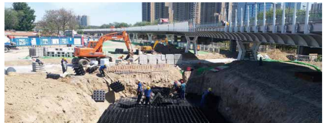
PP 蓄水池模块安装现场
