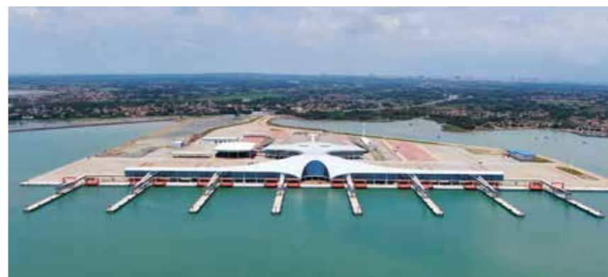
湛江徐闻港项目
