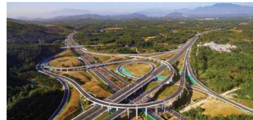
海南省万宁至洋浦高速公路顺利通车，标志着海南省东西南北快速大通道全面贯通
